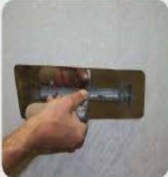
一貫してアルシブラン アルテにmax1%程度の水を調整し、ベネチアンコートでムラを作り薄く塗布します。
