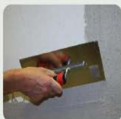
よく乾燥させたベースの上に接着剤用の1cm角の櫛目こてを用いてアルマトップ カーボン(約3 mm)の層を作ります。
