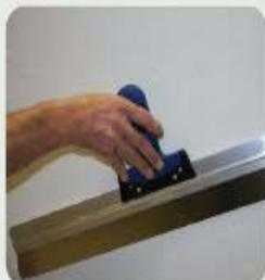
1層目のアルシリトSc カーボン Fをこてで厚さ1～2mm程度に塗布し、ベースコートの凹凸を滑らかにします。
