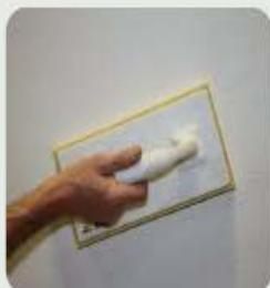
2層目のアルシリトSc カーボンFを1層目より薄く塗布し、1～2時間後に(天候など必要に応じて)水を付けたスポンジで表面を撫でて平滑にします。
