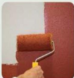
24時間以上経過し完全に乾燥させた後に、全面にアルシカラーSc (accs 1711)を塗布します。その後、アルシカラー メタリック インディアンサマーを塗布します。同系色を組合せることで深みが出て立体感が出ます。
