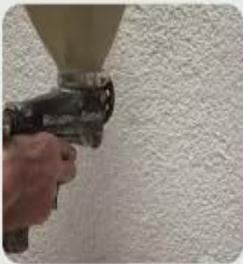
アルシカラー2回目の塗布後、直ちにアルセコ 漏斗ガンとコンプレッサーを使用し、低空気圧下でエフェクトグリマーを吹付けます。
